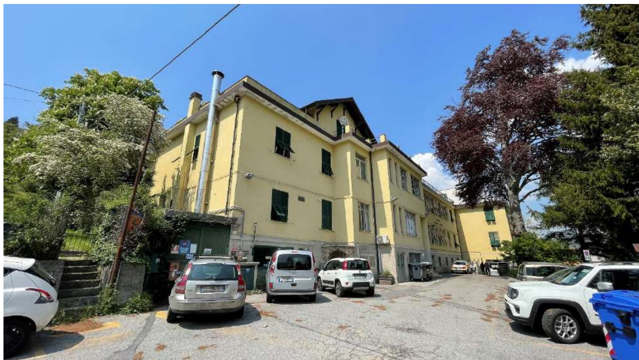
Prospetto Esterno dell'immobile esistente
